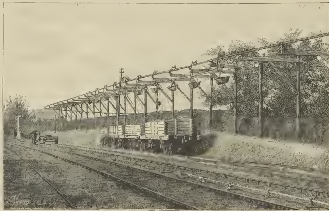
Fig. 2. — PUNTO DE PARTIDA DE LA TELPHER LINE DE GLYNDE, EN INGLATERRA (tomado de una fotografía)
